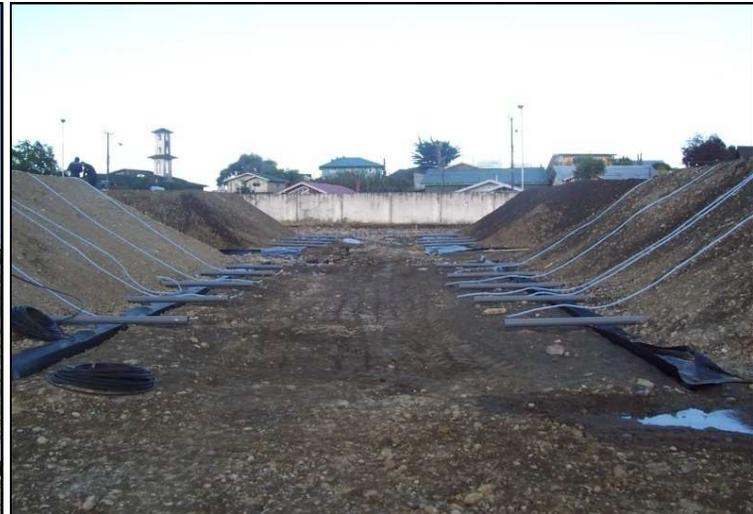
Disposición de Impermeabilización de Biopilas mediante PEAD y Geotextiles. Instalación de Red de Drenaje y Captación de Lixiviados. Instalación de Sistema de Aireación Forzada y Montaje de Suelos Clasificados.
