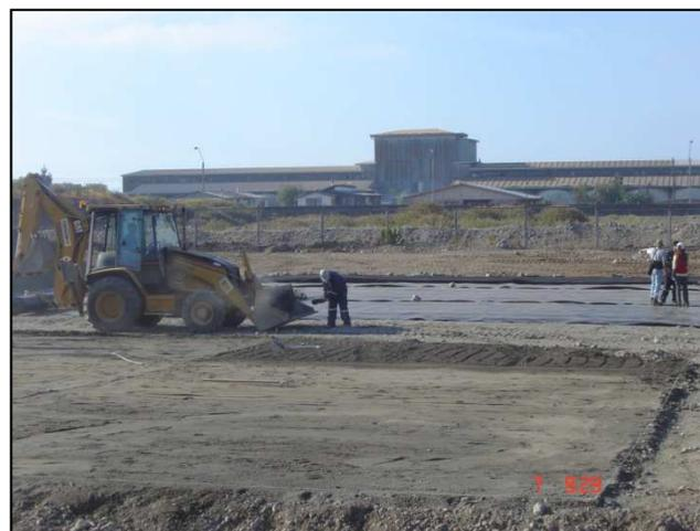
Movimiento de Suelos controlado para clasificación de suelos en cuanto concentraciones de contaminación. Posterior Segregación de Gravav y preparación de superficies impermeabilizadas.
