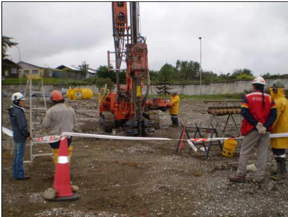
Ejecución de Sondajes y Pozos de Monitoreo mediante Hollow Stem Auger (Hélice Hueca).
