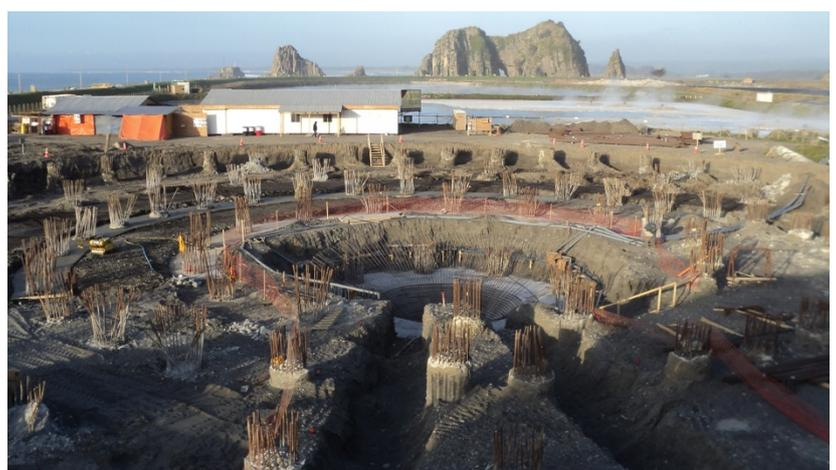
Imagen 7 – Pilotes Ejecutados para fundación de nuevo estanque.
