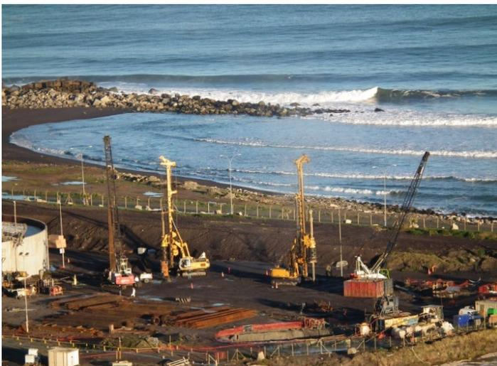
Imagen 4 – Ejecución Pilotes para Nuevo Estanque.
