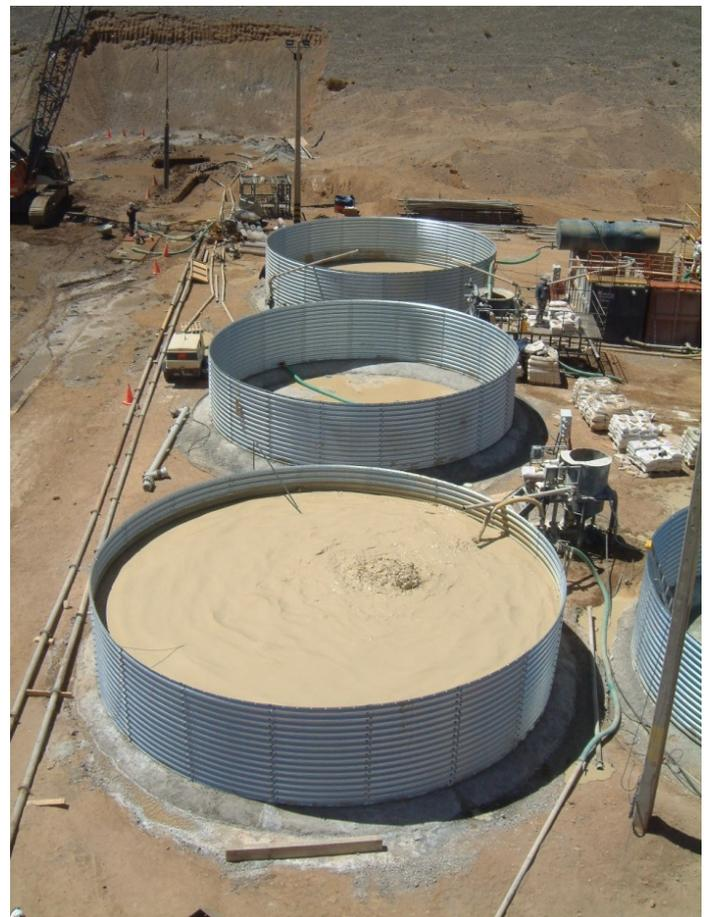
Planta de Lodos con estanques de 150 m<sup>3</sup> c/u y con capacidad de almacenamiento total de aprox. 700 m<sup>3</sup>
