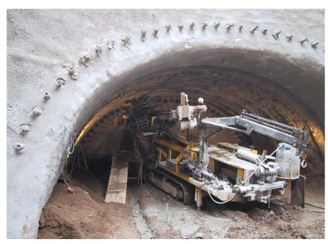
Foto 1 – Ejecución Paraguas del Túnel
