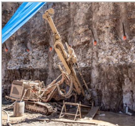
Foto 7: Ejecución de Anclajes a 45°
