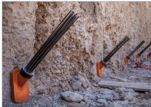
Foto 1: Placas especiales a 45° para el tensado
