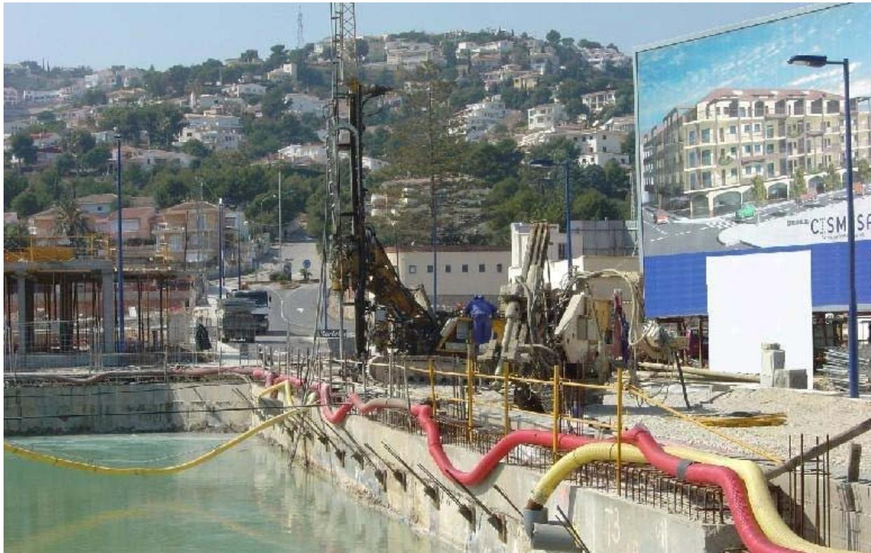
**Figura 7:** Ejecución una barrera hidráulica en el trasdós de un muro pantalla
