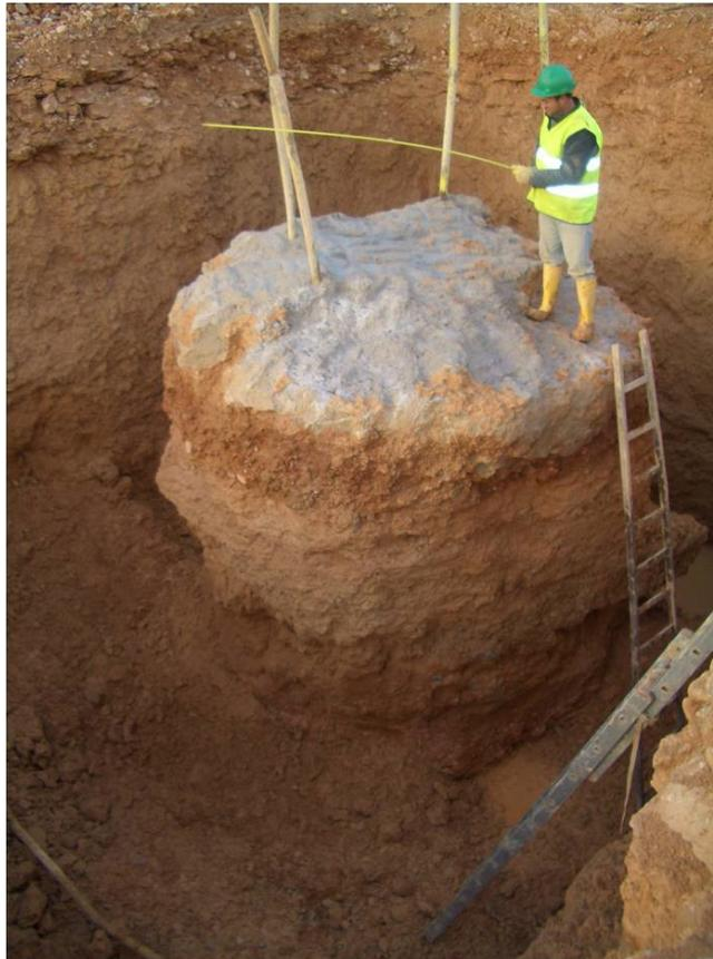
**Figura 11:** Campo de pruebas. Columnas de SuperJet Grouting en arcillas firmes
