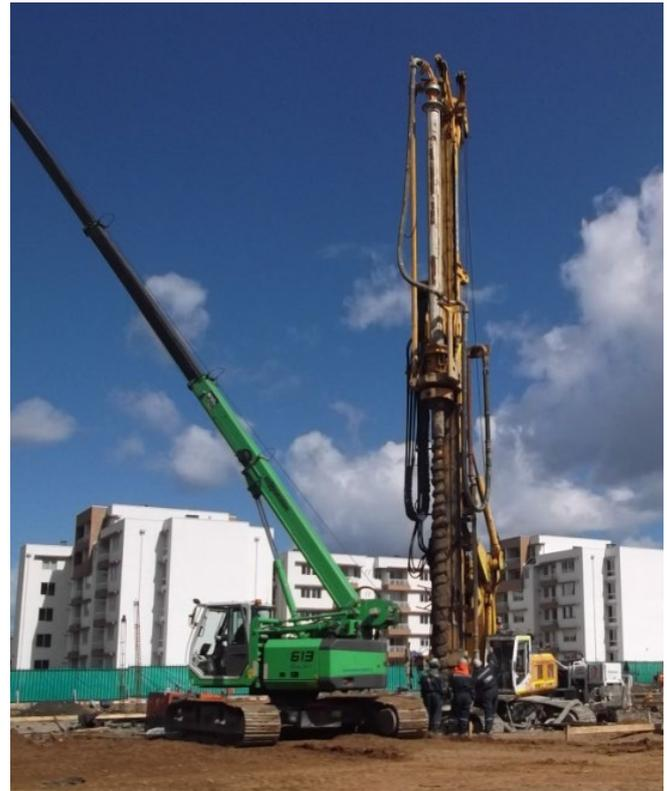
Ejecución Pilotes CFA en la obra.
