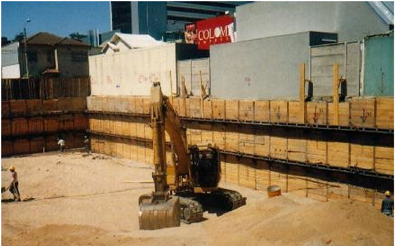
Foto 2 – Vista de la Obra.
