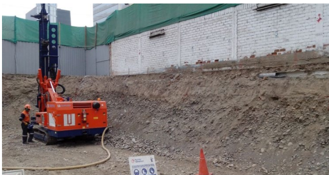
Se aprecia suelo conformado por grava en primer anillo.
