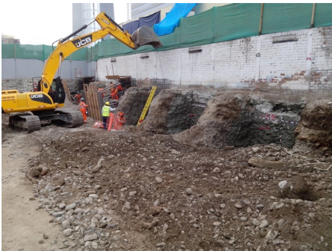
Apertura de paños siguiendo la secuencia recomendada por PTP.
