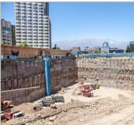
Foto 6: Excavación de obra a nivel de sello.
