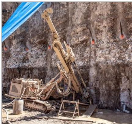
Foto 7: Ejecución de Anclajes a 45°
