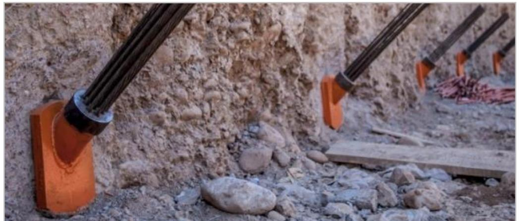
Foto 1: Placas especiales a 45° para el tensado
