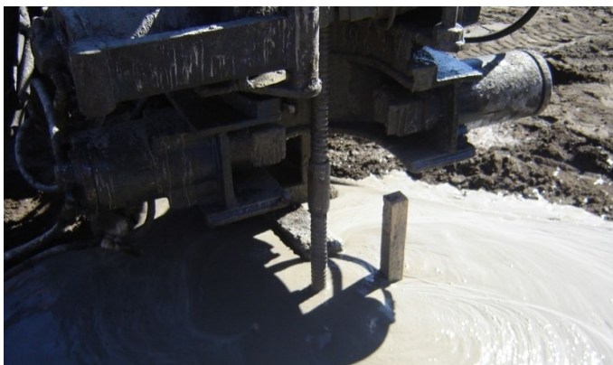
Foto 1 – Ejecución micropilotes Ischebeck TITAN®.
