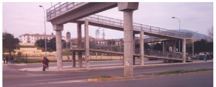
Foto 3 – Pasarela La Serena terminada.
