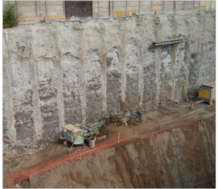
Foto 4 – Ejecución del segundo nivel de anclajes.
