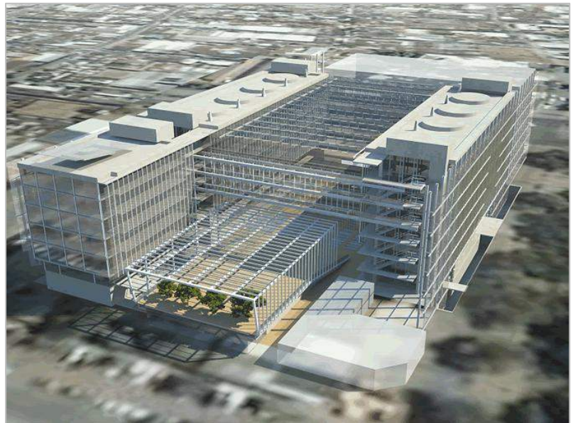
Figura 1 - Vista panorámica del edificio
