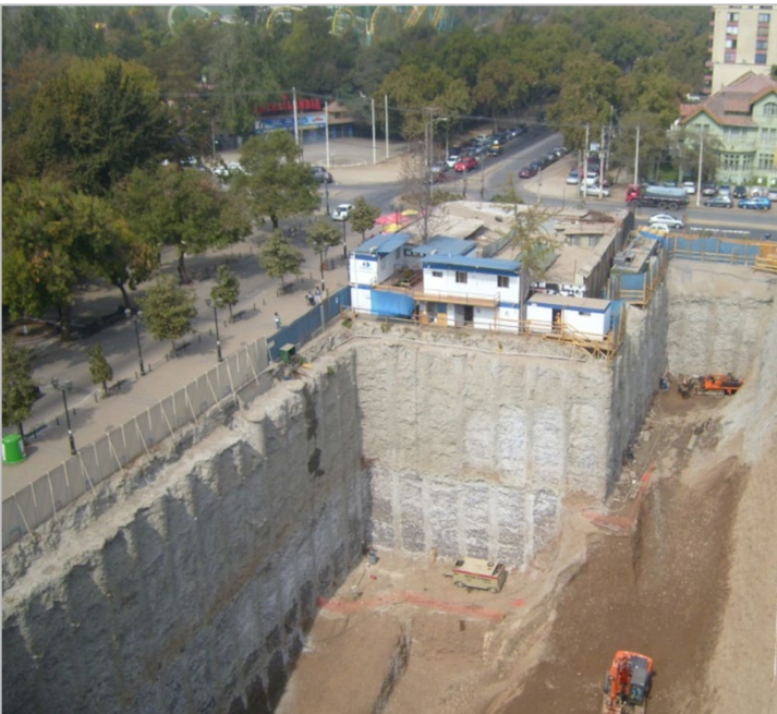
Foto 5 – Excavación hasta el tercer nivel de anclajes.
