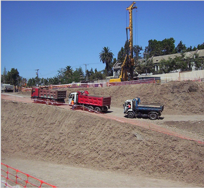
Foto 3 – Ejecución de Pilotes.
