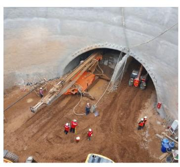
Foto 2 – Ejecución de Paraguas en Sidedrift del Túnel.
