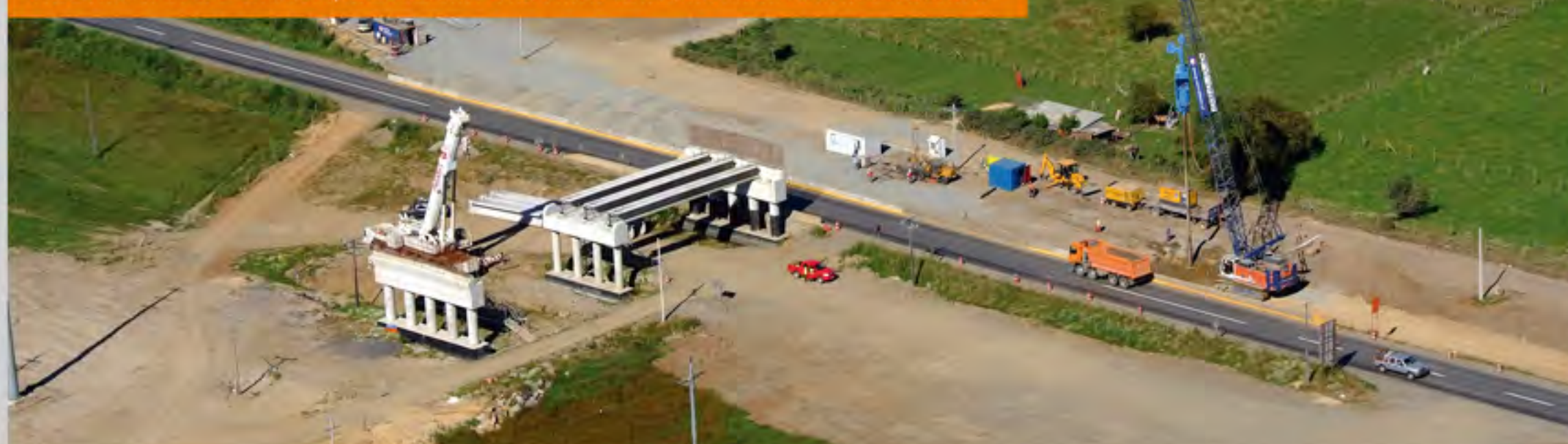
COLUMNAS DE GRAVA, Concesión Vial Ruta 160. Mercado: Infraestructura.
