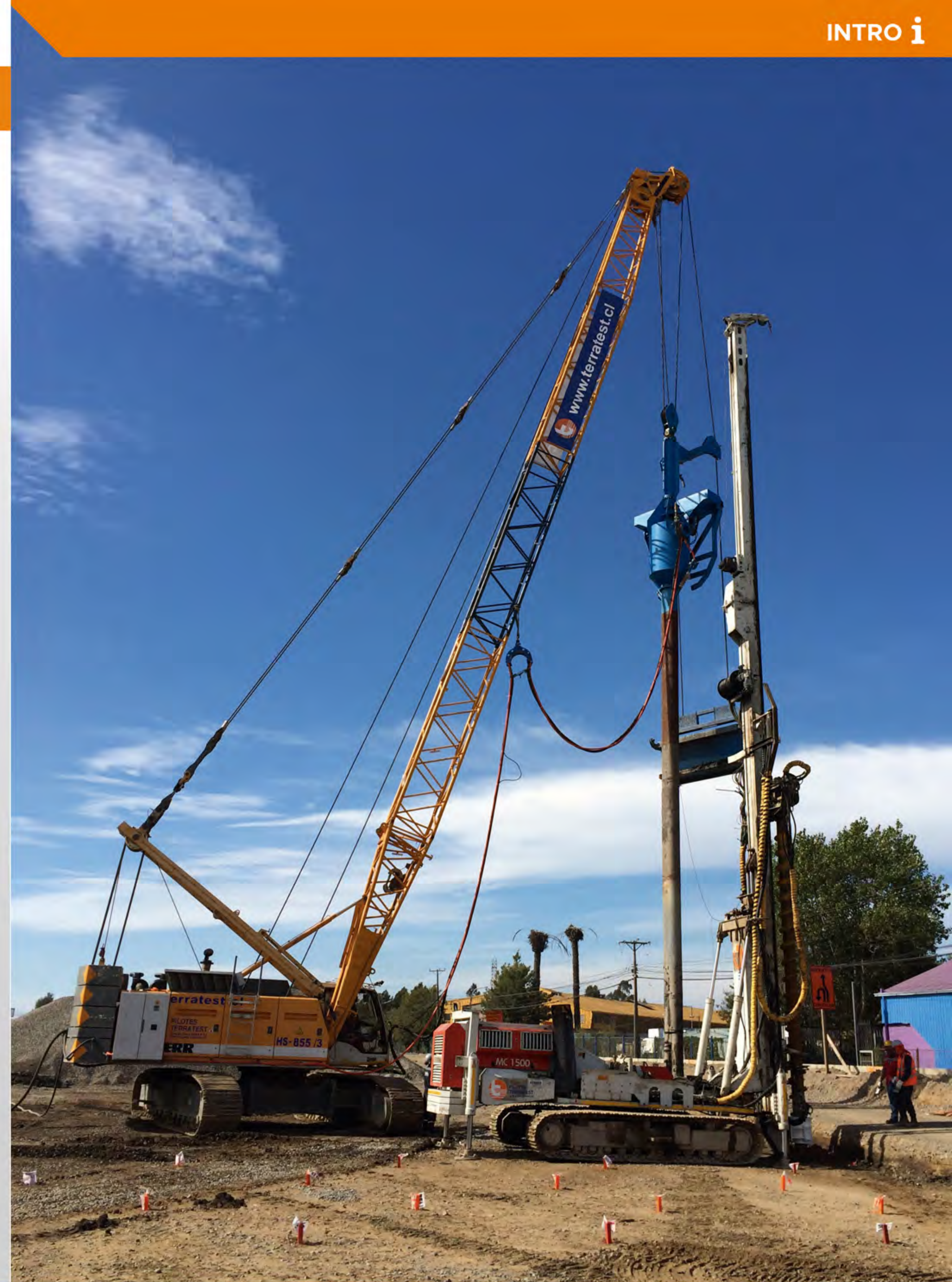
COLUMNAS DE GRAVA, Viaducto Alessandri, Concepción. Mercado: Infraestructura.
