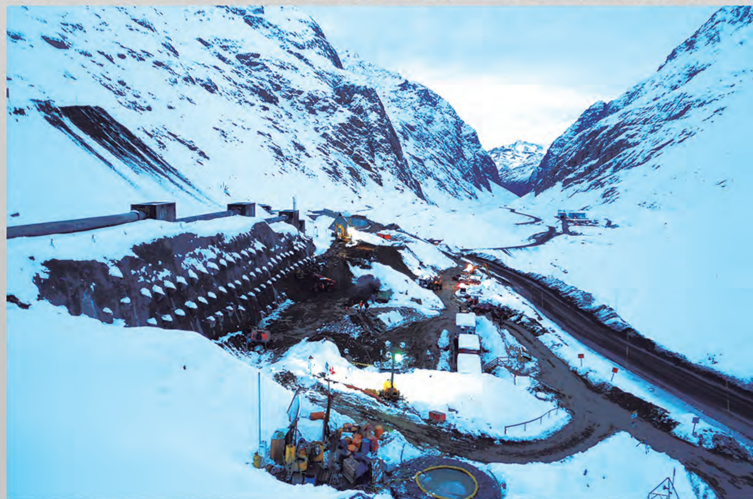
Anclajes de Gran Capacidad, Estabilización de talud, División Andina, CODELCO..
