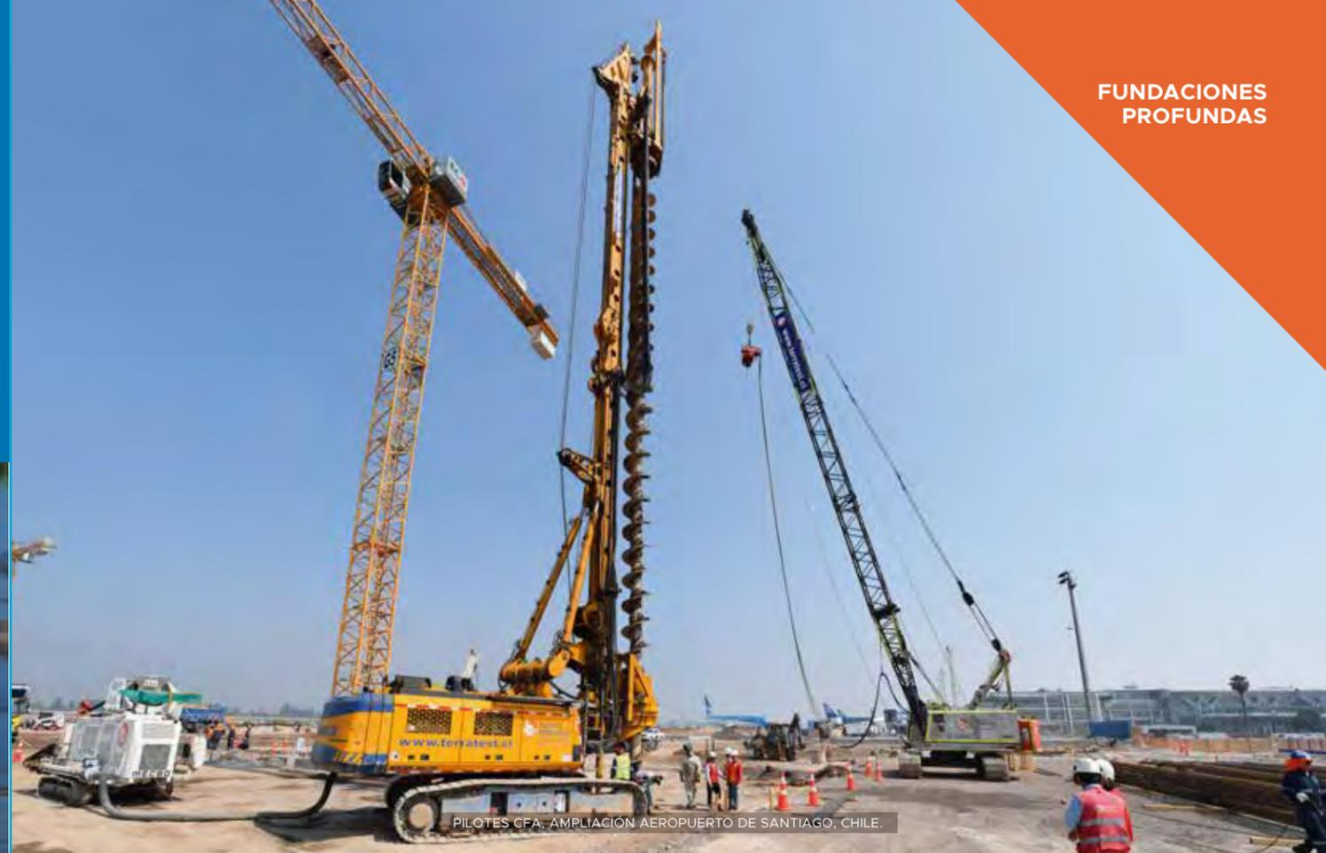
PILOTES CFA, AMPLIACIÓN AEROPUERTO DE SANTIAGO, CHILE.
