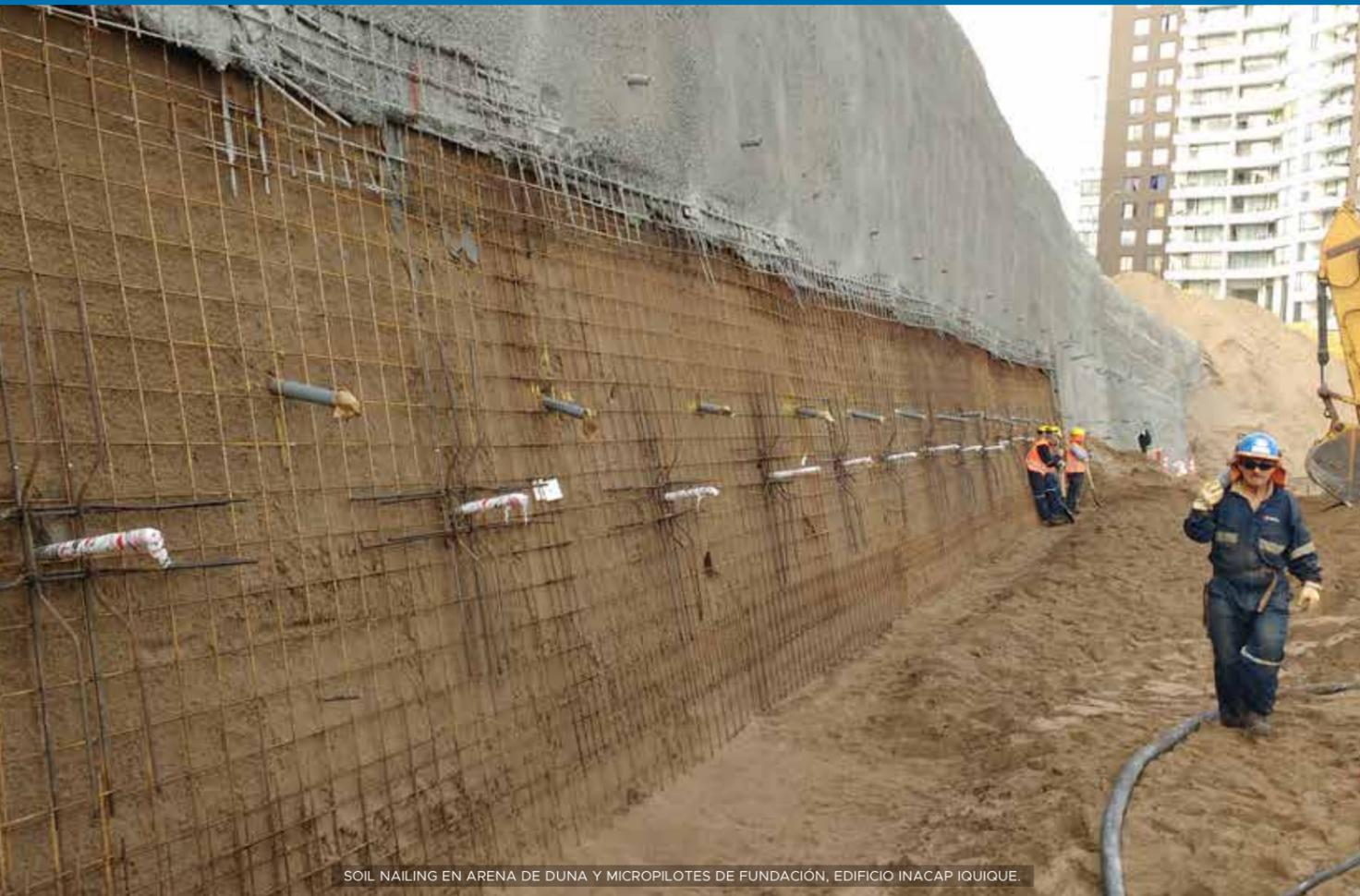
SOIL NAILING EN ARENA DE DUNA Y MICROPILOTES DE FUNDACIÓN, EDIFICIO INACAP IQUIQUE.
