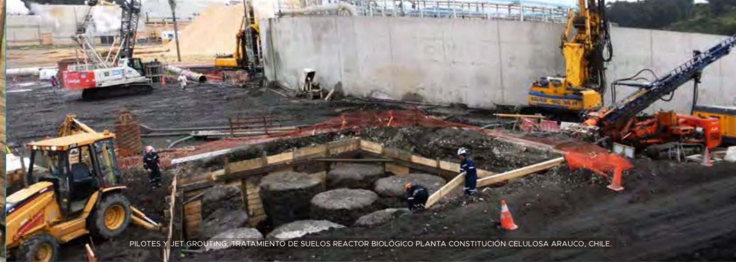
PILOTES Y JET GROUTING, TRATAMIENTO DE SUELOS REACTOR BIOLÓGICO PLANTA CONSTITUCIÓN CELULOSA ARAUCO, CHILE.
