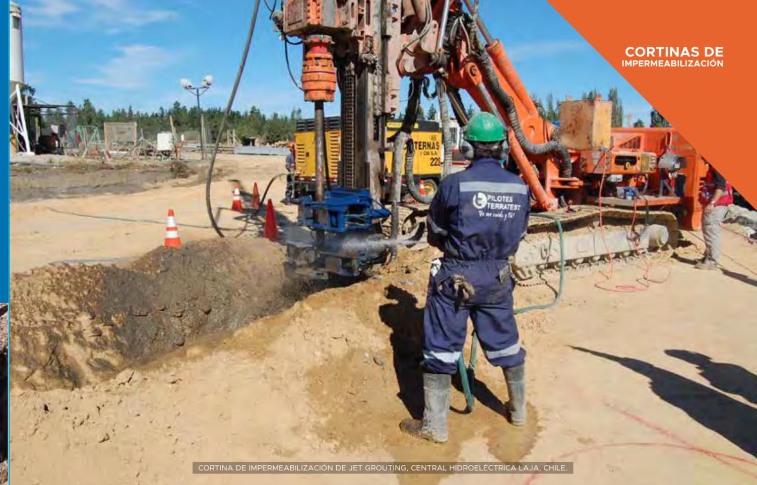
CORTINA DE IMPERMEABILIZACIÓN DE JET GROUTING, CENTRAL HIDROELÉCTRICA LAJA, CHILE.
