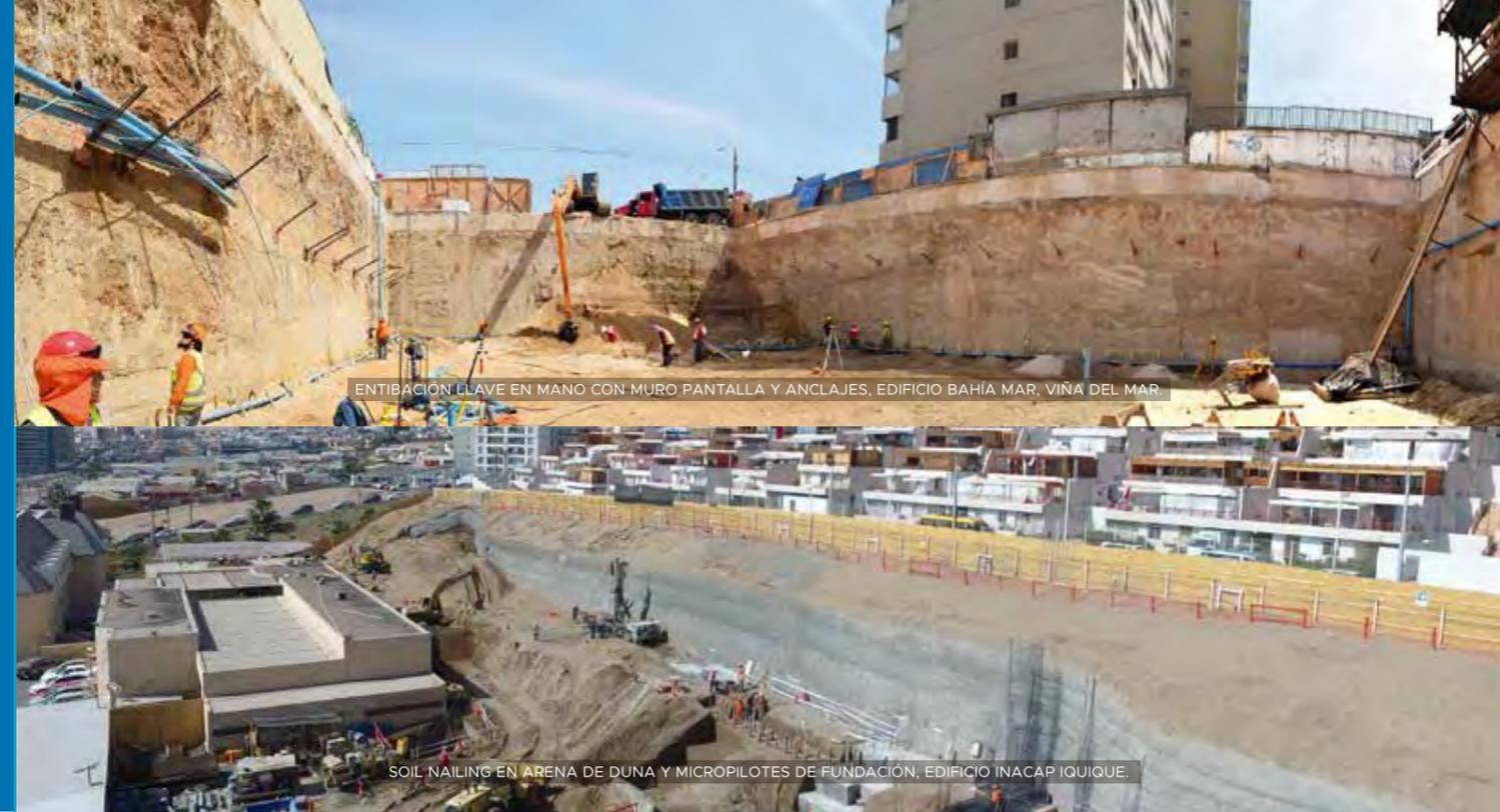
ENTIBACIÓN LLAVE EN MANO CON MURO PANTALLA Y ANCLAJES, EDIFICIO BAHÍA MAR, VIÑA DEL MAR.
