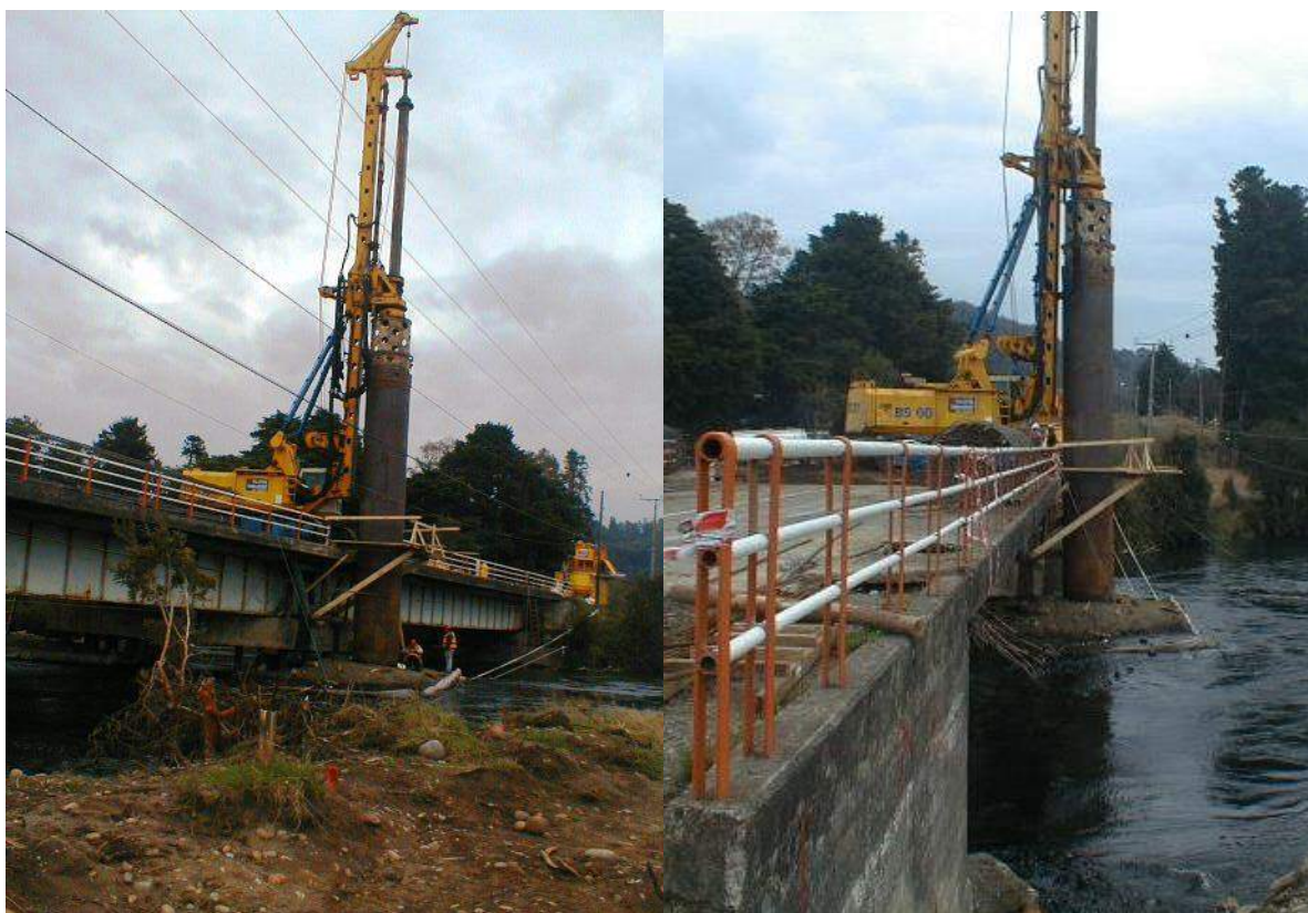
FIGURA 17 Puente Maullín (8 pilotes \phi 1500\text{mm} de 16 metros).
