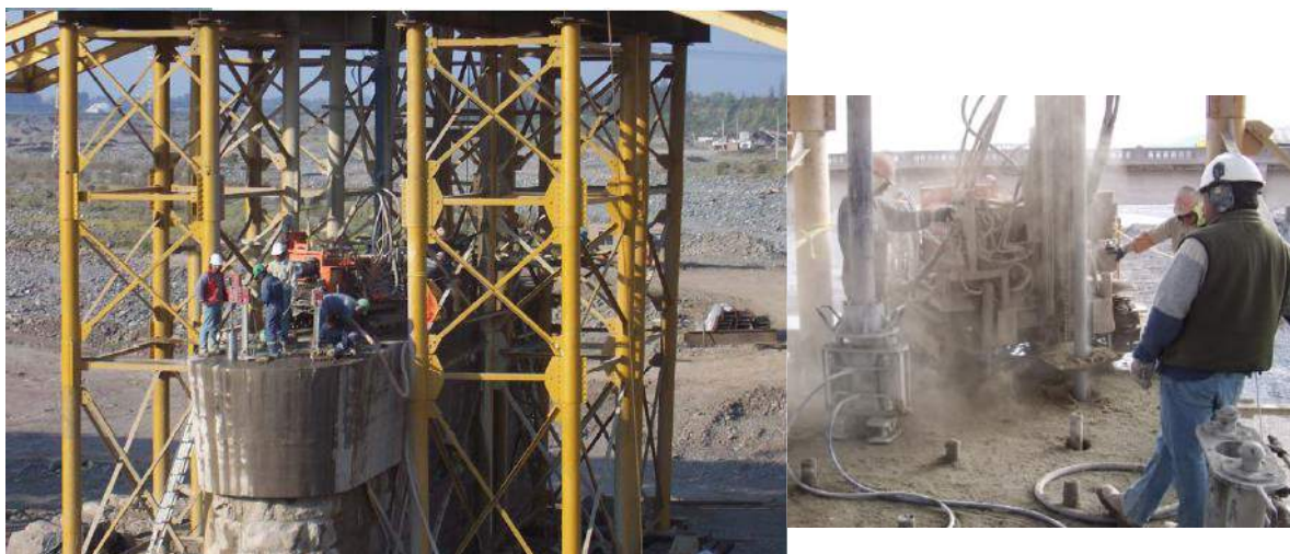
FIGURA 5 Ejecución de micropilotes sobre la cepa 8.
