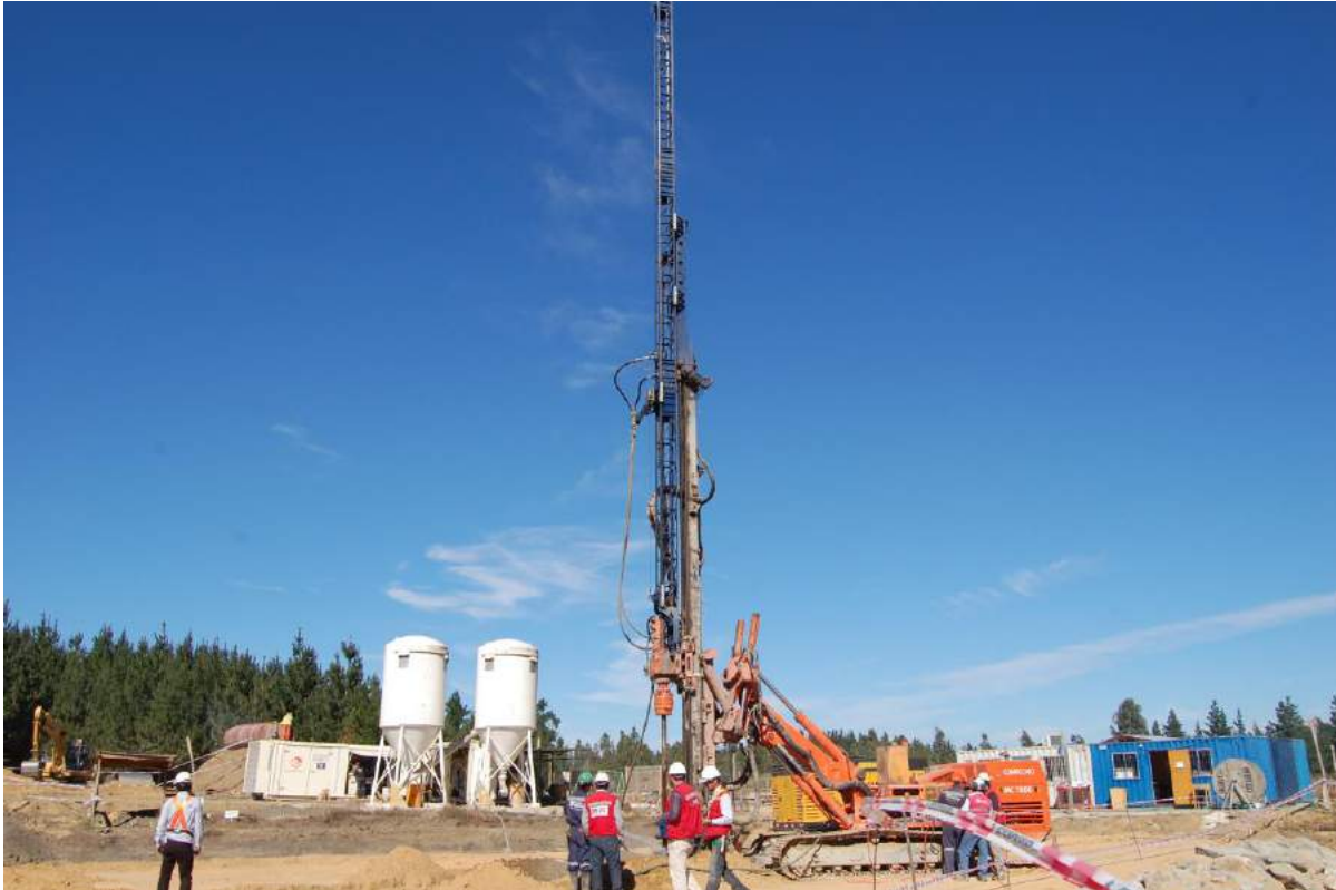
FIGURA 11 Equipamiento de trabajos de jet grouting.
