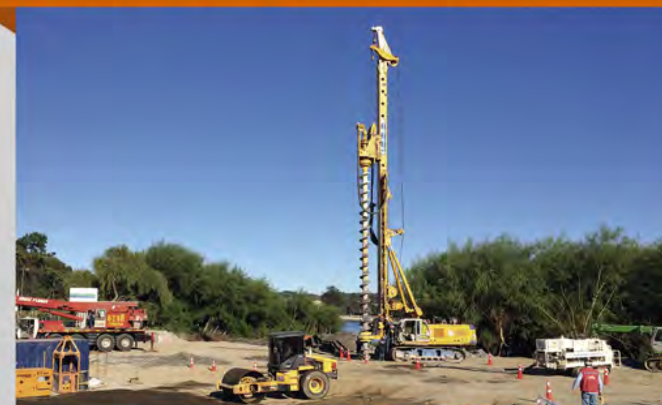
FUNDACIÓN CON PILOTES CFA DE HÉLICE CONTINUA.
