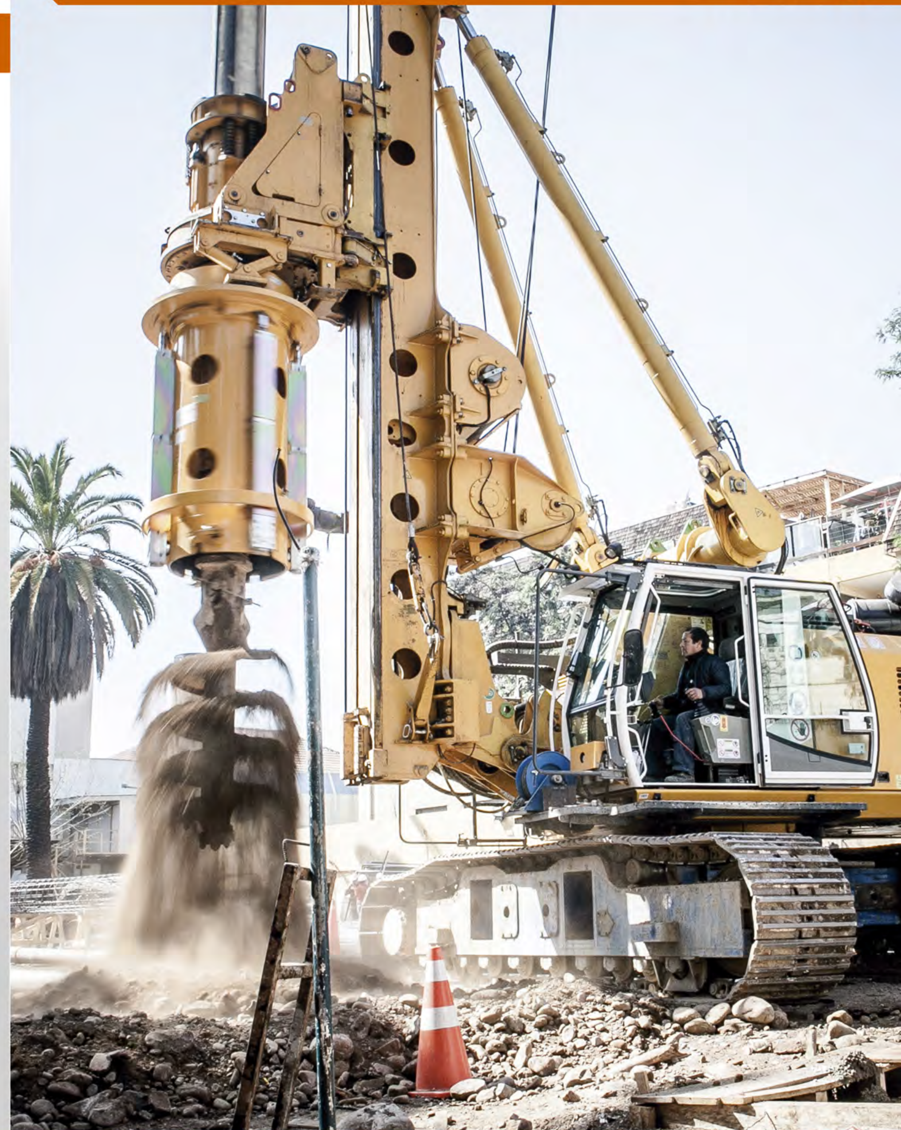
PILOTES DE 1500 mm, Edificio Postgrado Universidad Mayor.
