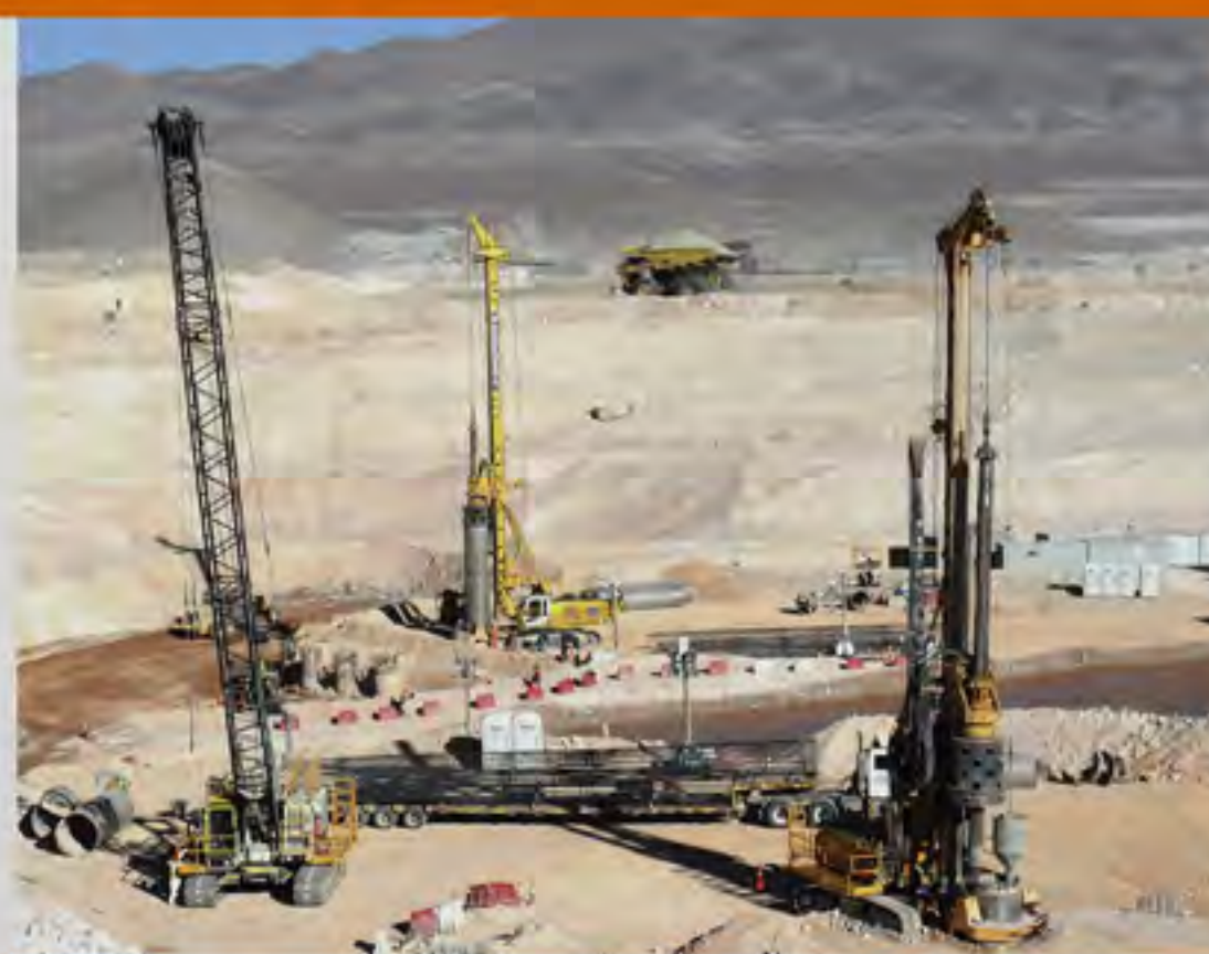
FUNDACIÓN CHANCADORES, sobre relleno.
