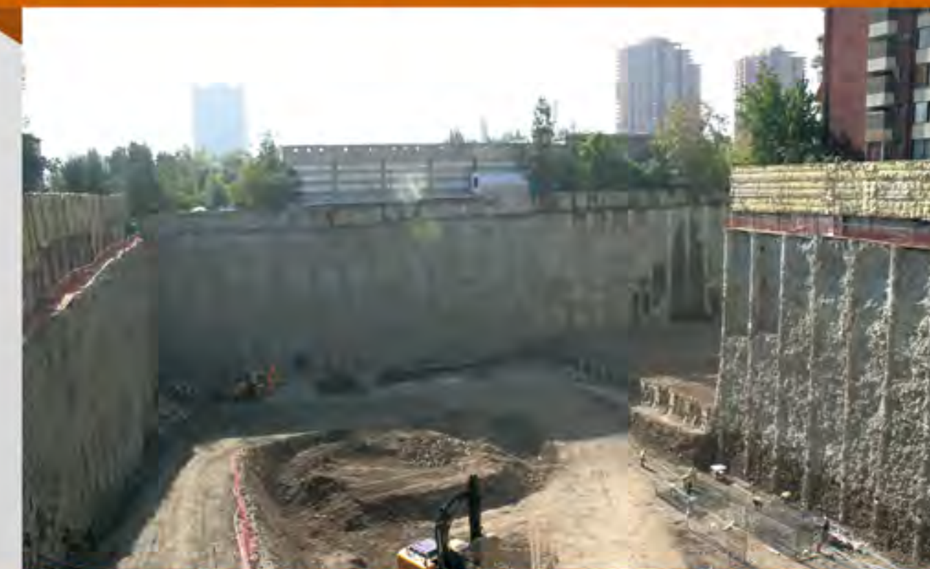
ENTIBACIÓN MIXTA DE PILOTES CON ANCLAJES POSTENSADOS.
