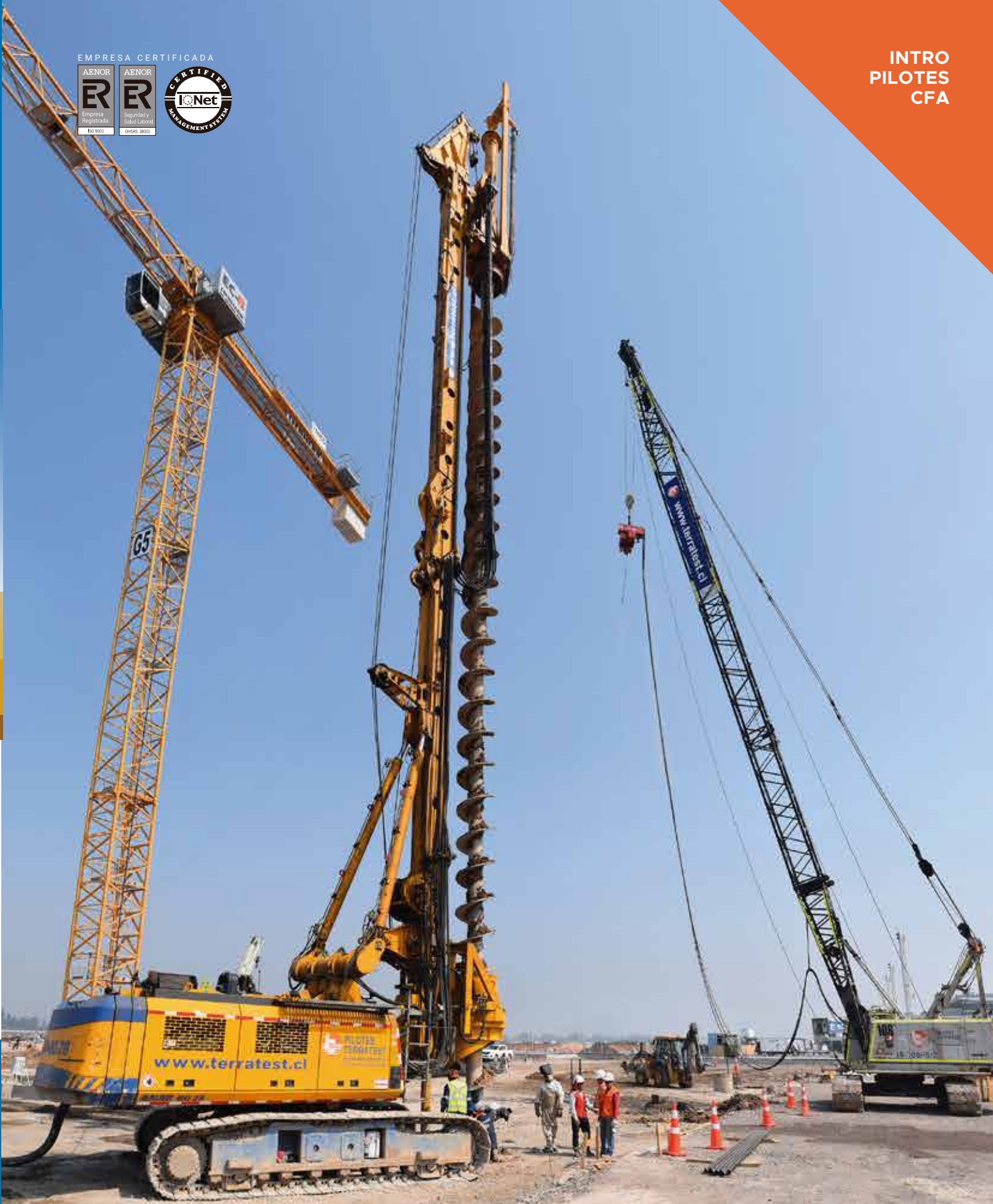
PRIMEROS PILOTES CFA Ø 1000 Y 1200 MM EN CHILE DE 15 M DE PROFUNDIDAD, AMPLIACIÓN AEROPUERTO INTERNACIONAL DE SANTIAGO.
