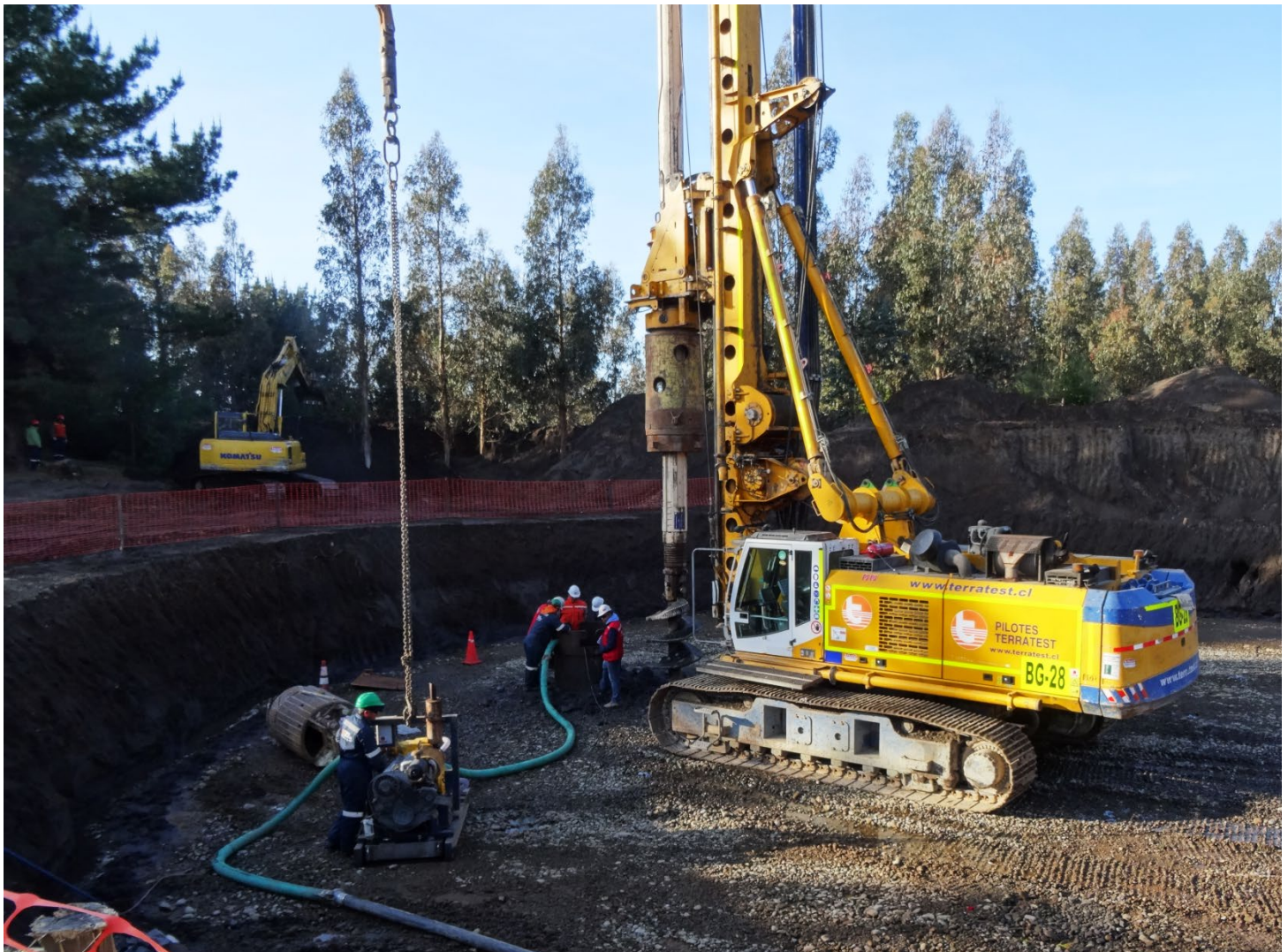
Vista general de obra.
