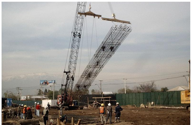
Foto 3 – Colocación Armadura de los Barrettes.
