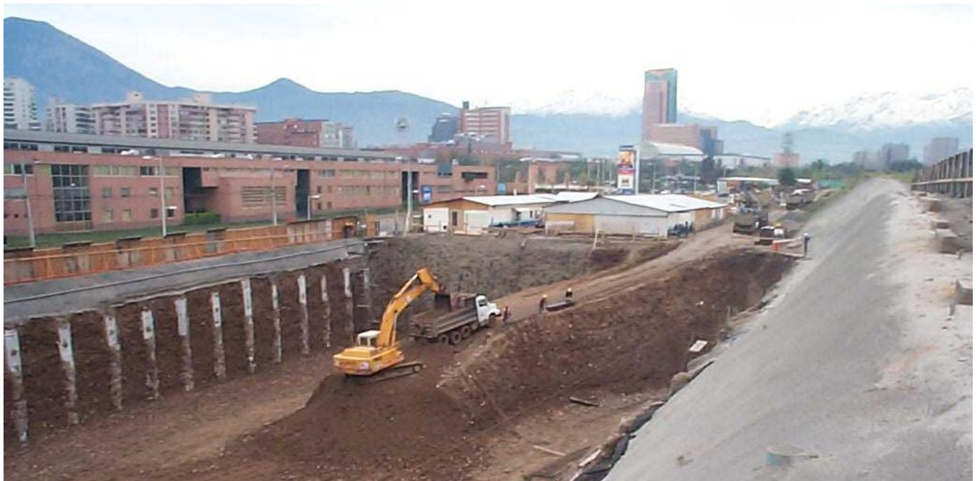
Foto 1 - Vista general de la obra
