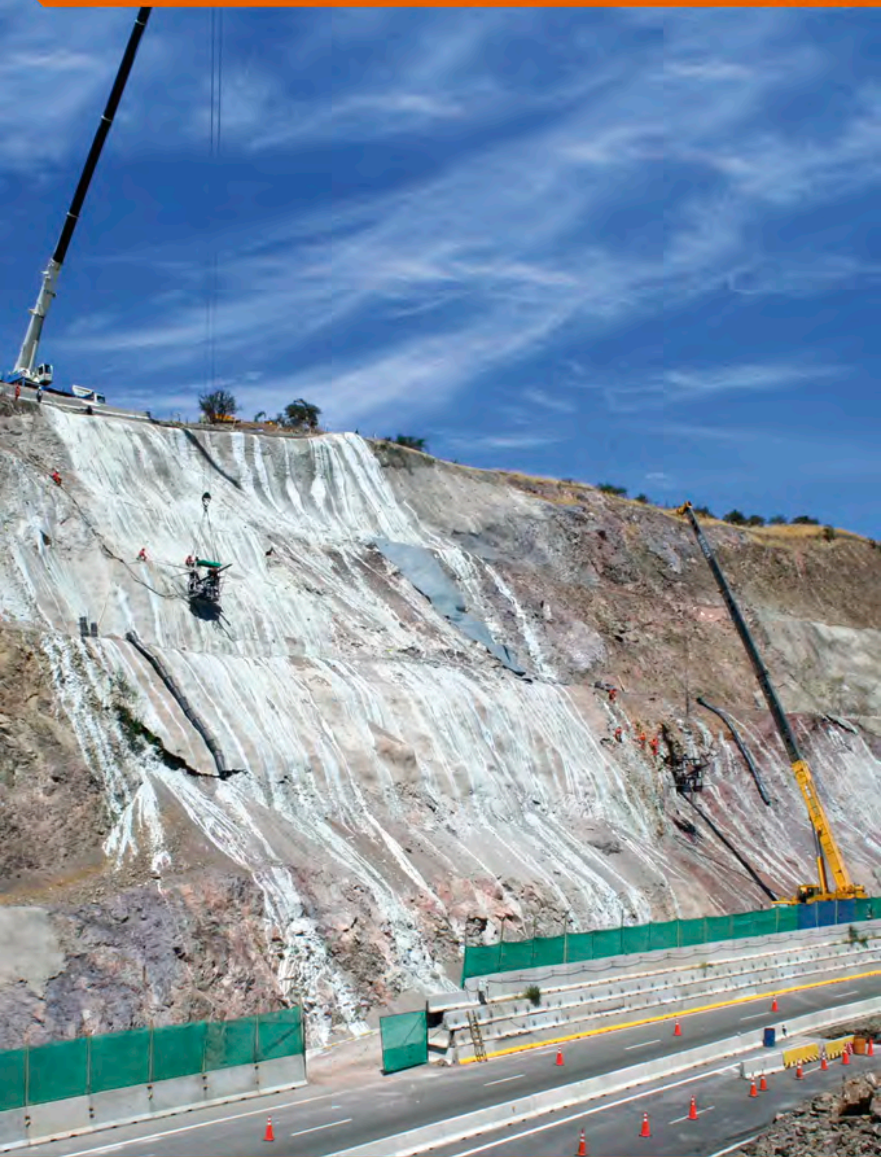
MÚLTIPLE EJECUCIÓN DE SOIL NAILING, Reforzamiento Talud Nororiente Km 10000
