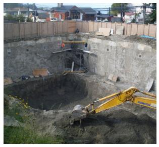
Foto 1 – Vista del Muro Pantalla y Excavación general
