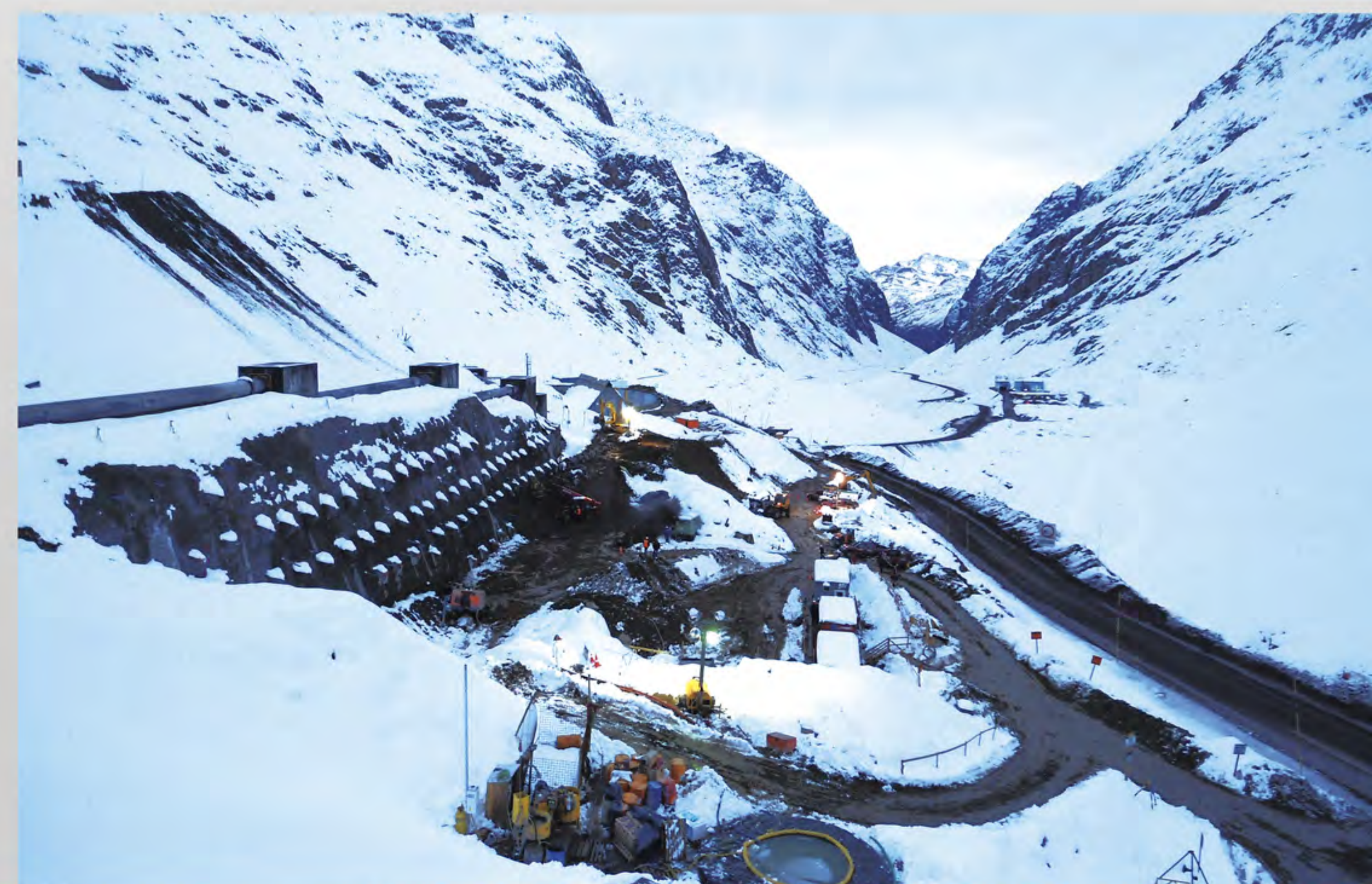
ANCLAJES DE GRAN CAPACIDAD, Estabilización de talud, División Andina, CODELCO..
