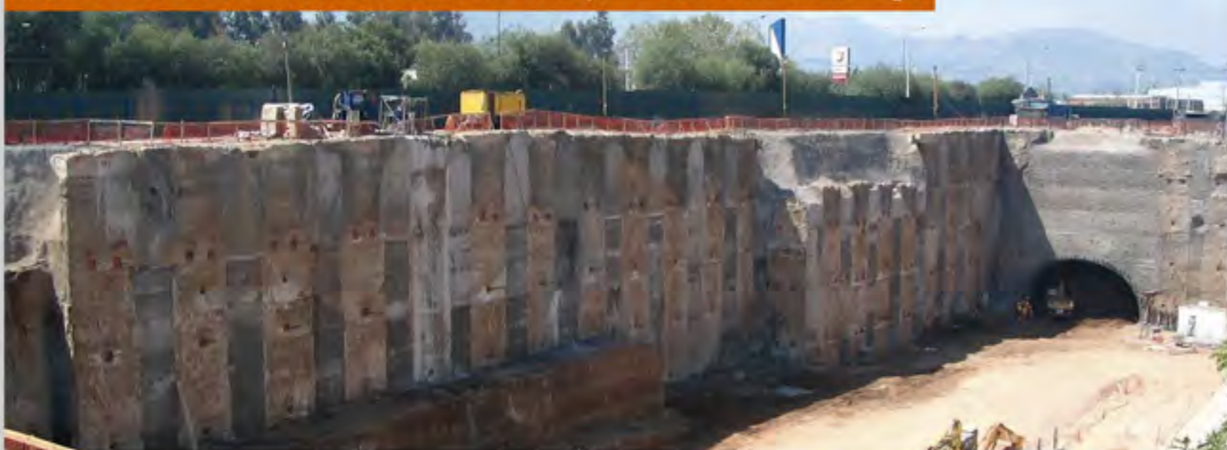
MURO PANTALLA DISCONTÍNUO DE 3.565,5 m 2 , Estación Vespucio - Recoleta, Metro de Santiago.
