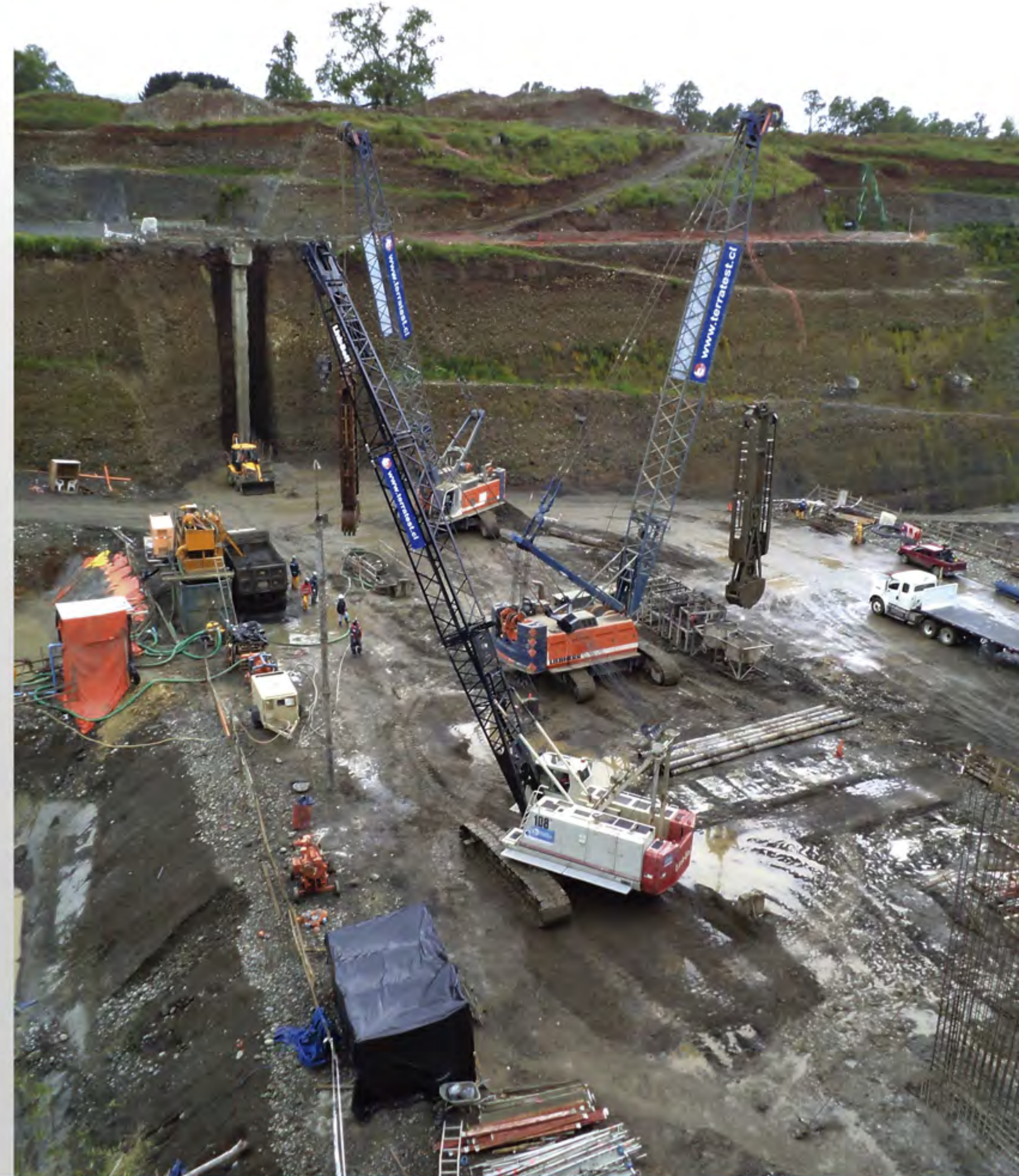
MURO PANTALLA, Central Hidroeléctrica Rucatayo.
