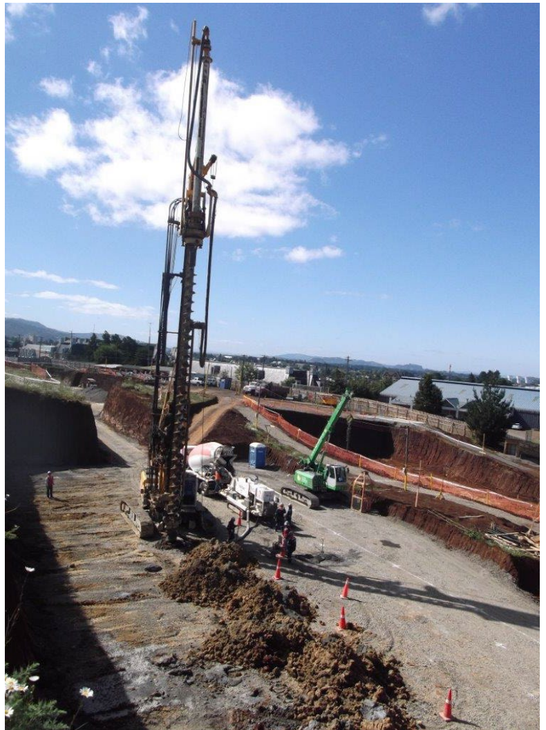
Imagen 3, 4 y 5 – Ejecución de Inclusiones Rígidas mediante CFA.
