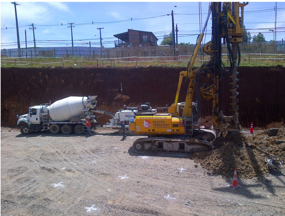
Imagen 1 y 2 – Ejecución de Inclusiones Rígidas mediante CFA en Condominio Alta Vista.
