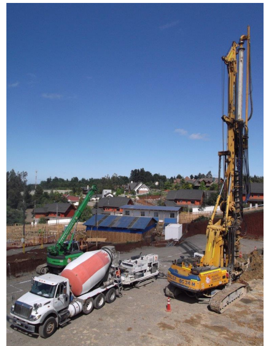
Imagen 1 y 2 – Ejecución de Inclusiones Rígidas mediante CFA en Condominio Alta Vista.
