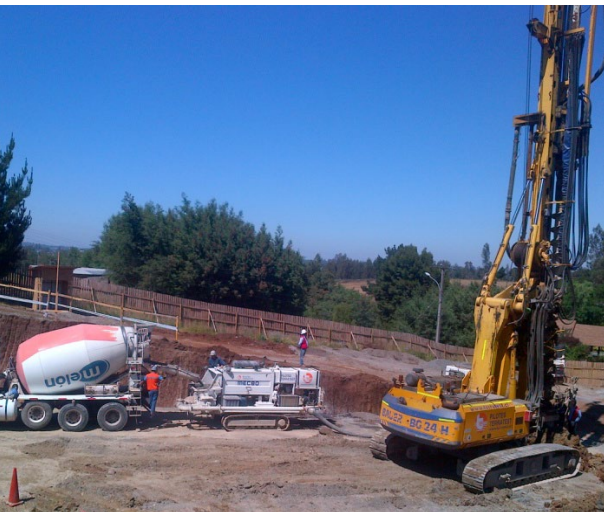
Imagen 3, 4 y 5 – Ejecución de Inclusiones Rígidas mediante CFA.
